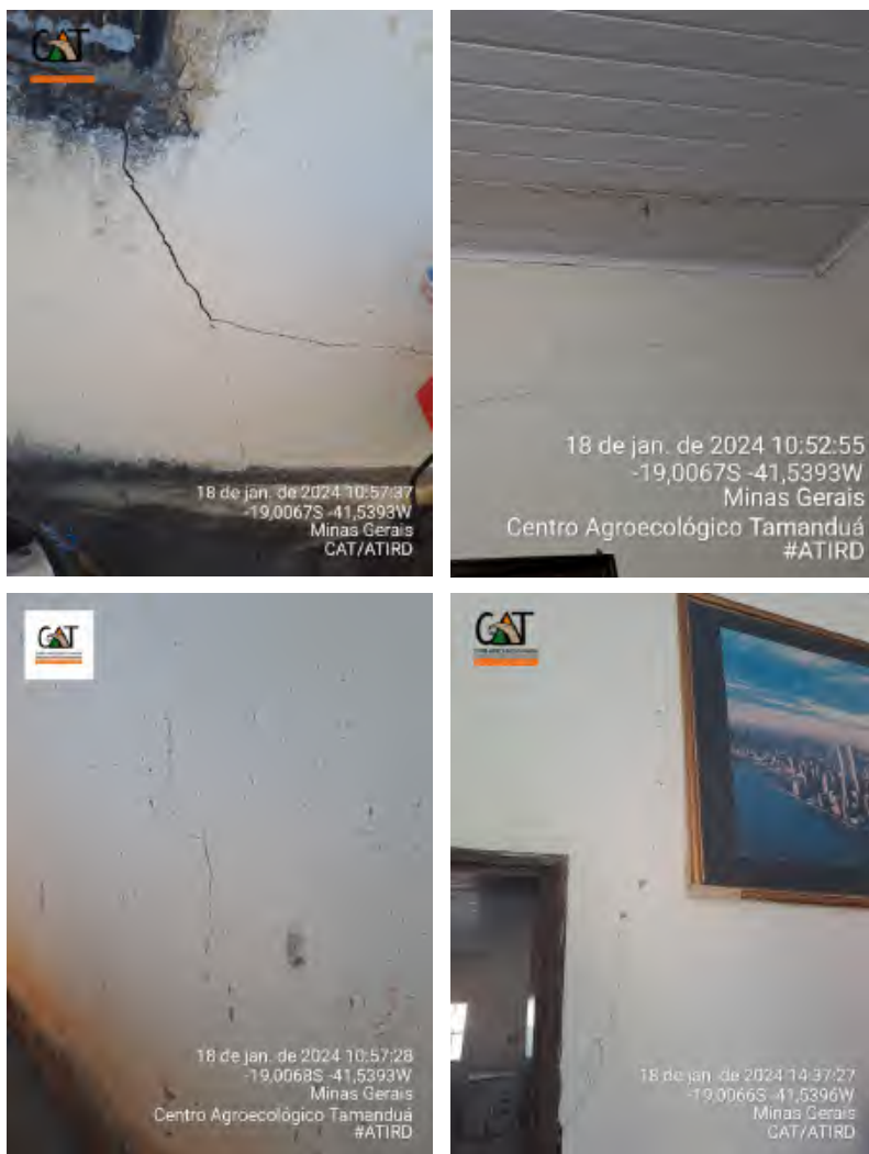
Imagem 1: Rachaduras nas residências em Galiléia
